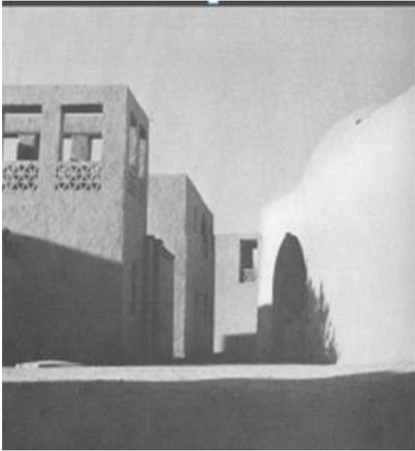
شوارع فى القرنة الجديدة المصدر : كتاب عمارة الفقراء حسن فتحى
